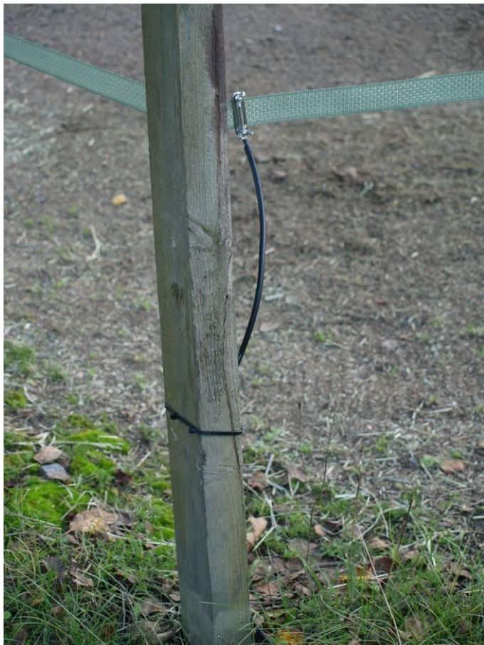
Крепление высоковольтного кабеля
